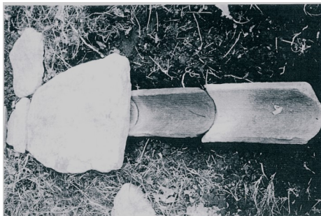
Photo 8 - Eléments du drainage de l'aqueduc de la Jourdanie
